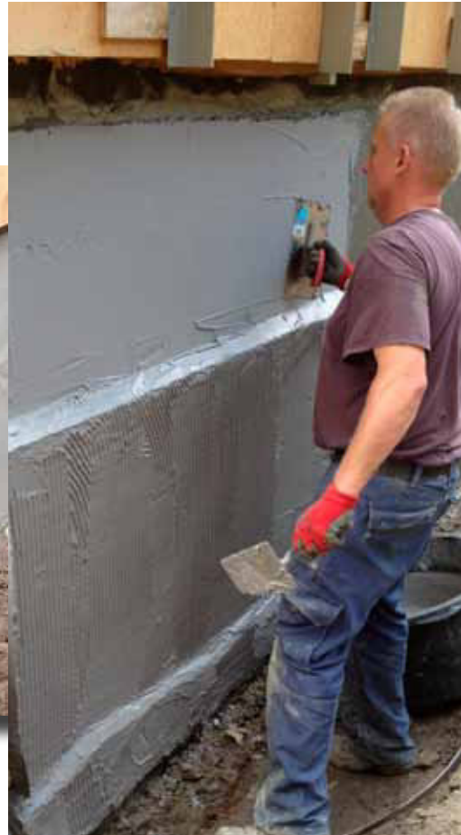
Bild oben: vorbereiteter Untergrund; Bild rechts: Verarbeitung von KÖSTER NB 4000.
